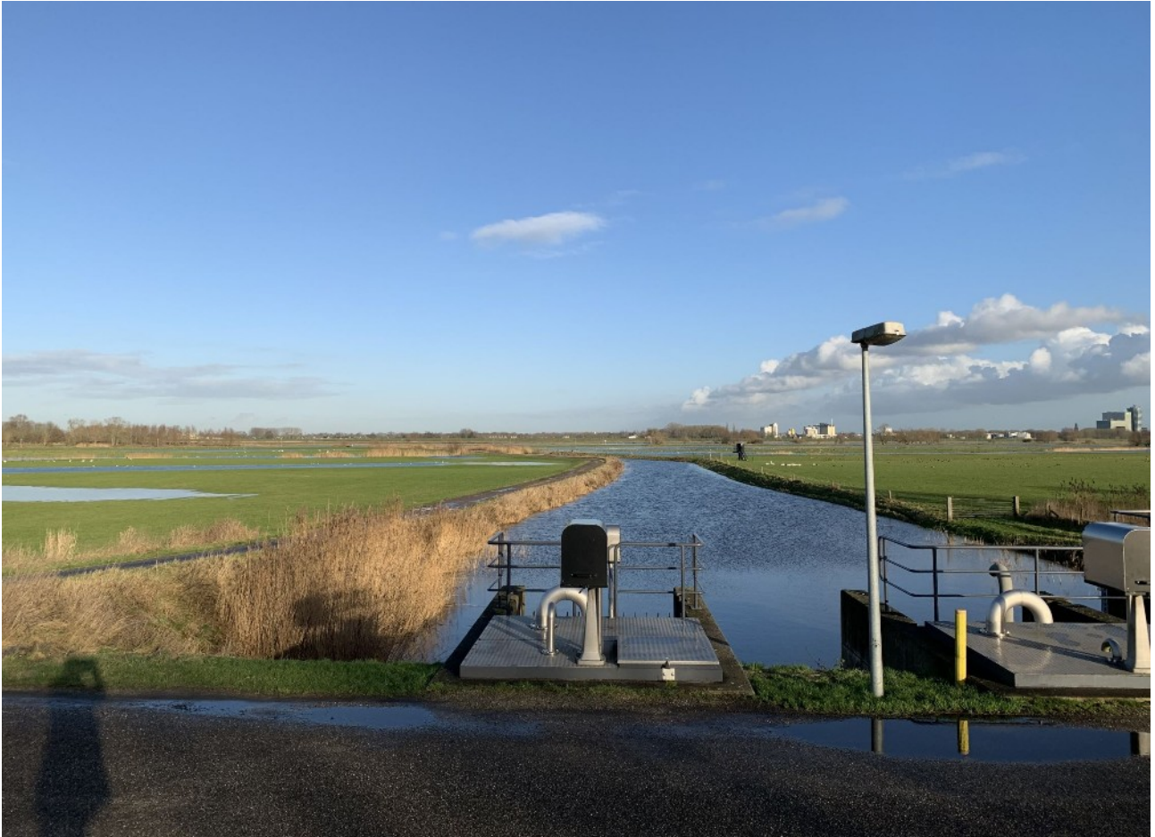
Afbeelding 1. Van Zalk ..... Uitwateringsgemaal Antlia, waar de grens tussen Hattem en Zalk van de IJssel het land in gaat. Kijkrichting naar het oosten (de IJssel), rechts op de achtergrond Zwolle 1
