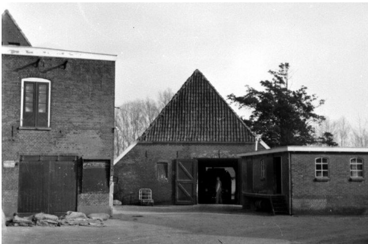
Afb. 4.26 De gebouwen van de Coöperatieve Landbouwvereniging Enter begin jaren dertig van de 20 e eeuw in het noordeind van het dorp.
