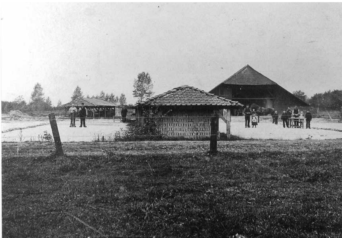
Afb. 4.10 Een van de steenbakkerijen van Rohaan aan het begin van de 20 e eeuw.
