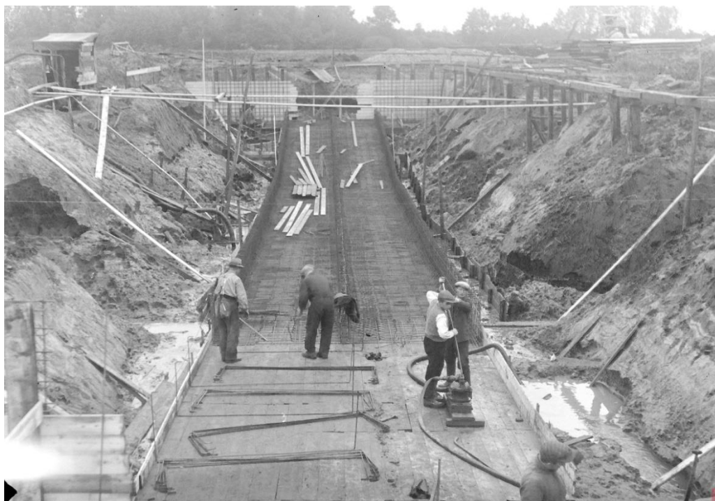
Figuur 4.4 Aanleg grondduiker in Dinkelkanaal, dit werd met de hand gedaan (HCO, 2015e).
