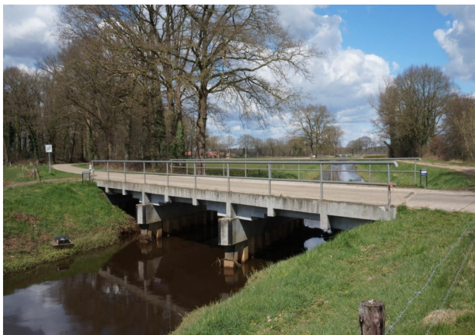
Figuur 4.18 Brug over provinciale weg. Deze brug is van verhard staal gemaakt. En heeft een aansluiting naar Duitsland.
