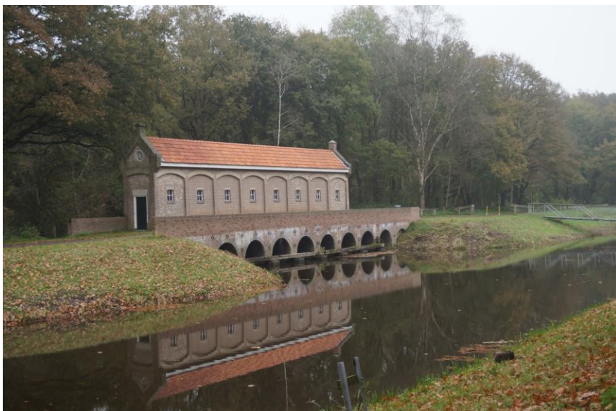
Figuur 5.3 Schuivenhuisje in kanaal Almelo-Nordhorn in Harsveldseweg, Denekamp (eigen materiaal).
