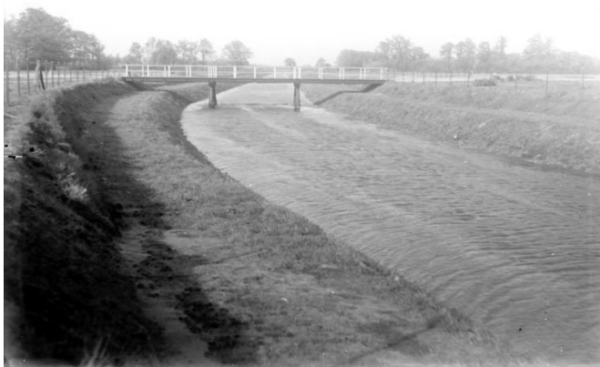
Figuur 3.6 Dinkelkanaal na aanleg in 1936 bij Breklenkamp (HCO, 2015d).
