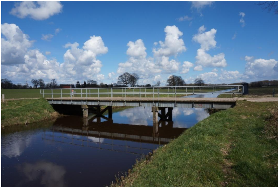
Figuur 4.16 Tweede brug over het Dinkelkanaal.
