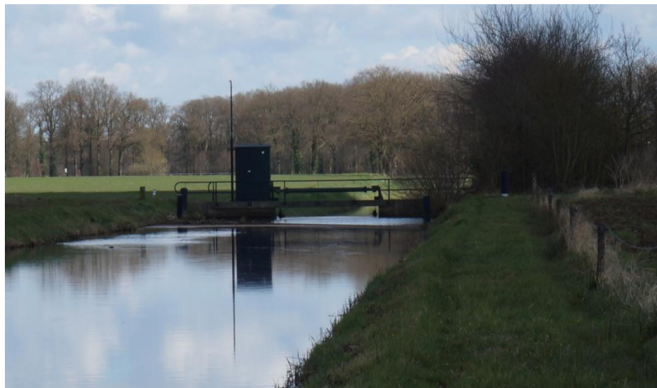
Figuur 4.17 Derde brug over Dinkelkanaal, met kleine stuw. Op de bestek tekening uit 1934 was hier alleen een brug aangegeven.
