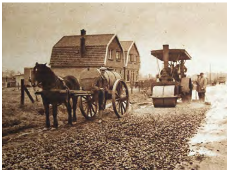
Afb. 4.7 Vanaf de tweede helft van de negentiende eeuw werden verbindingswegen tussen dorpen en steden verhard. Deze 'macadam'-wegen waren opgebouwd uit drie lagen verschillende steenslagsoorten, van grof naar fijner, die tussentijds werden ingewalst.
