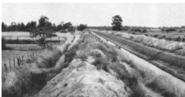
Afb. 5.18 De afwatering van gebieden werd sterk verbeterd tijdens ruilverkavelingen. Links een niet verbeterde sloot, rechts een verbeterde watergang, waarvan de afvoercapaciteit vele malen groter was. Locatie: Vriezenveen.
